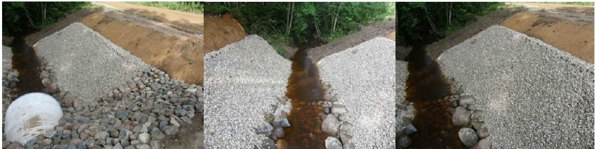
Kombineeritud kivikindlustus geotekstiilil ja geokärg killustik täitega RMK objektil.
